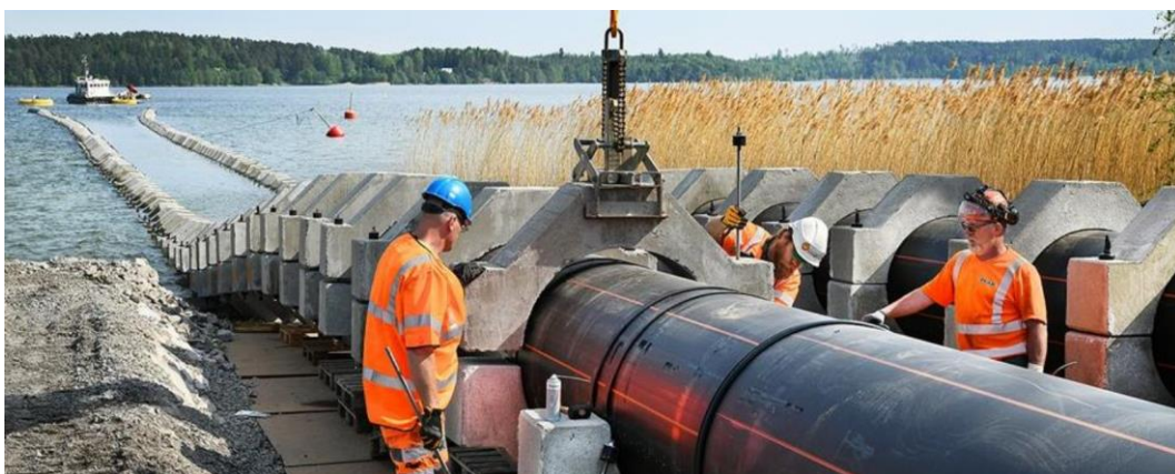
Figur 4. Exempel på en sjöförlagd ledning av PE-rör med betongvikter (foto: PEAB-Marin AB)
