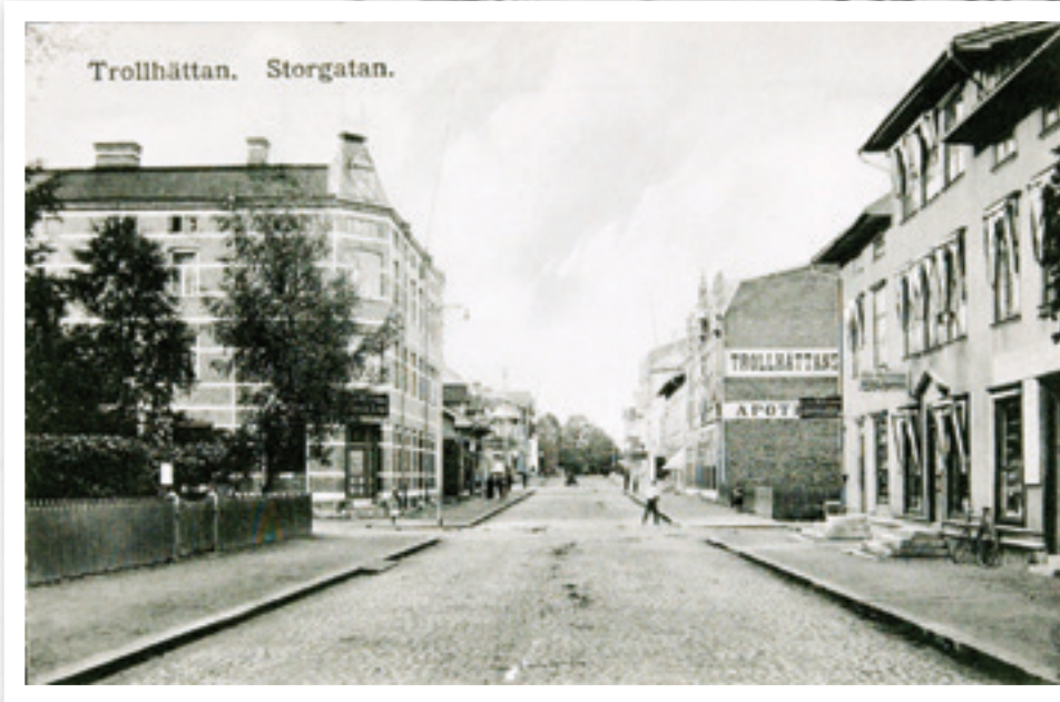
Storgatan. Vatten- och avloppsledningar är nedlagda och gatan iordningställd. Foto år 1908.
