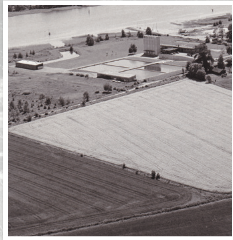
Flygfoto av vattenverket på Överby. Till vänster i bild syns intagsbassängen.
