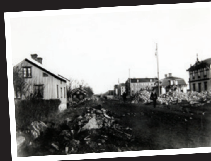
Kungsgatan med anläggningsarbete för vattenledningar. Foto år 1907.
