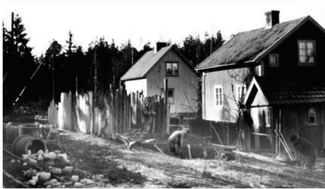
Arbete med rörläggning. Ryrs backe utmed Daggkåpan i Skoftebyn. Foto år 1950.
