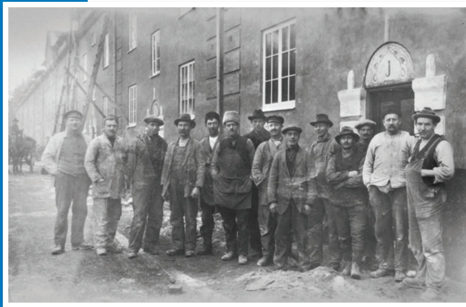
Arbetare vid byggandet av kvarteret Polisen på Margaretavägen (nu Nordewallsgatan) i Egnahem 1921.
