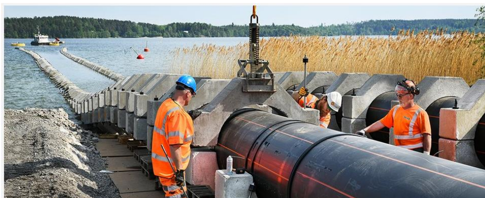
Figur 4 Exempel på Sjöförlagd ledning, PE-rör med betongvikter (foto: PEAB-Marin AB)
